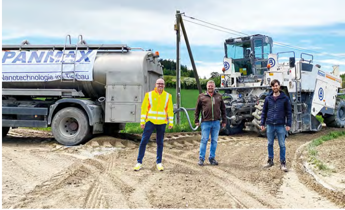
Erster Bürgermeister Andreas Strauß, Bauamtsleiter Ralf Ringlstetter und Bauingenieur Michael Hutzenthaler (v.l.) sind von der neuen Sanierungstechnologie überzeugt. Bild: Markt Ergolding
